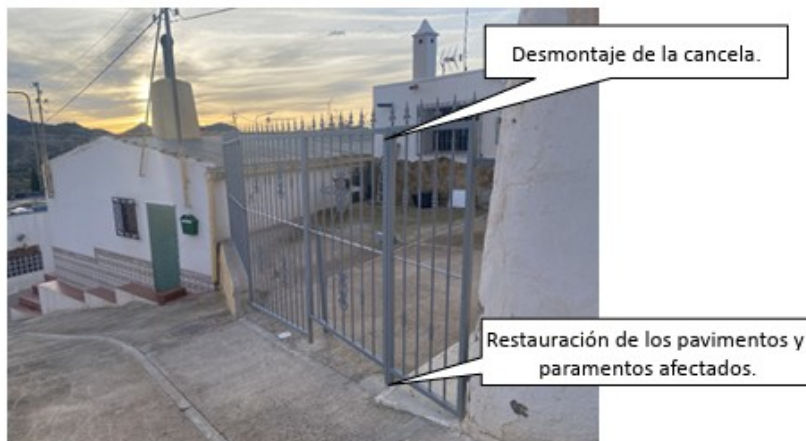
Fotografías de la cancela ejecutada.
