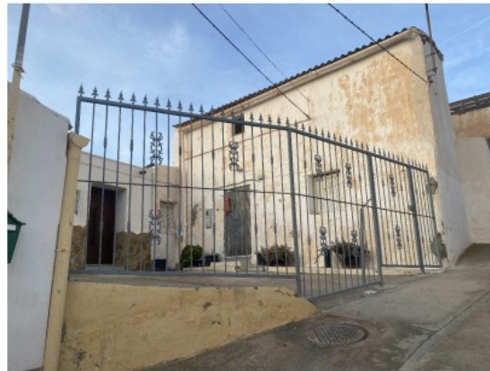
Fotografías de la cancela ejecutada.
