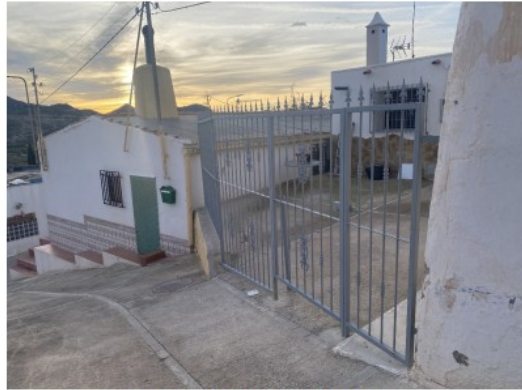
Fotografías de la cancela ejecutada.
